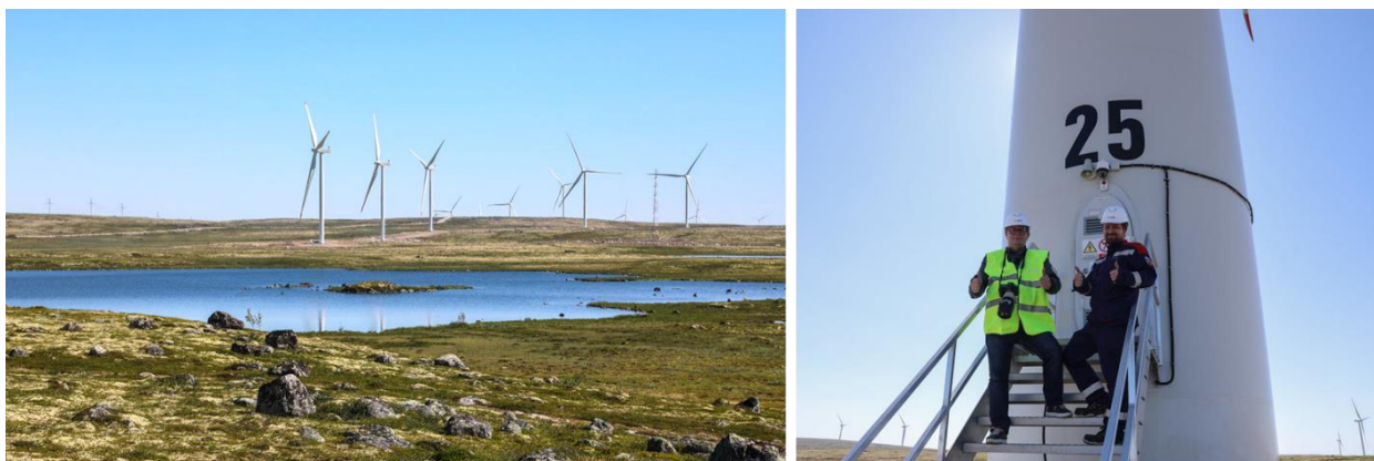
Рисунок 12.4 - Кольская ветроэлектростанция (ВЭС) – самая крупная ветряная электростанция за полярным кругом
