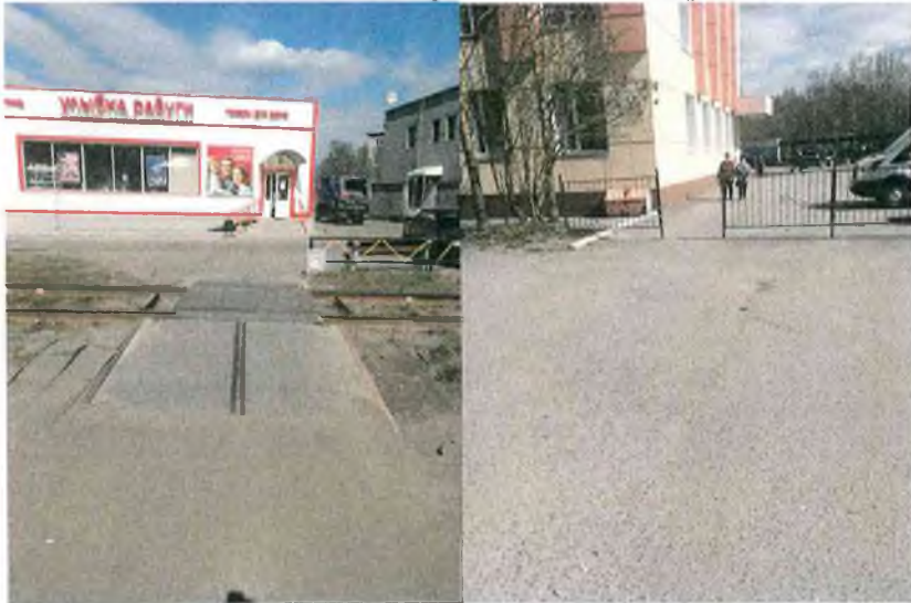
Фото № 1: Подъездные пути, вход на территорию объекта.
