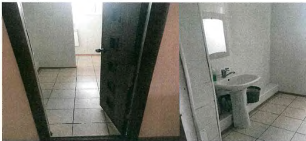
Фото № 4-6: Санитарно-гигиеническое помещение
