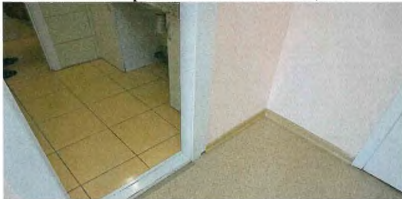
Фото № 5: Санитарно-гигиеническое помещение
