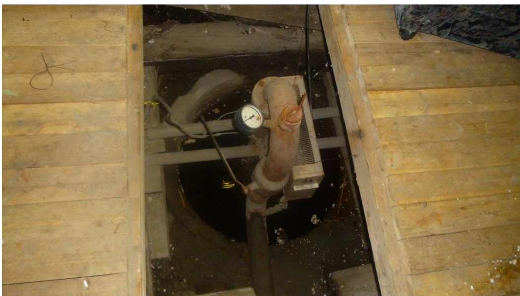
Рисунок 2.2.1.2 – Оголовок скважины
